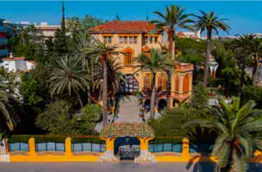
El Xalet Bonet, un dels edificis patrimonials més destacats de Salou, és obra de l'arquitecte Domènec Sugranyes i Gras, deixeble i col·laborador d'Antoni Gaudí.
